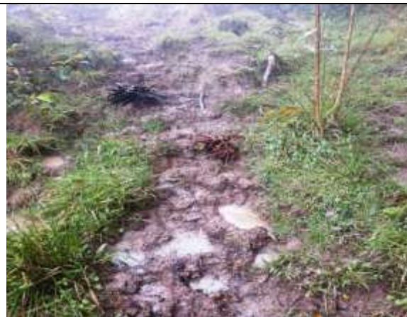
Ilustración 17 Falta de Mantenimiento para zanjas de escorrentía.
