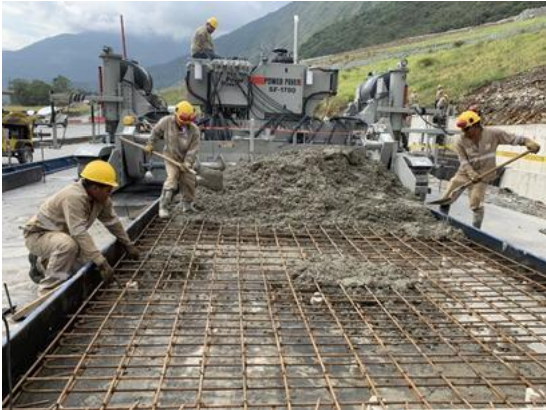
Ilustración 9. Riego de concreto y conformación de la losa.
