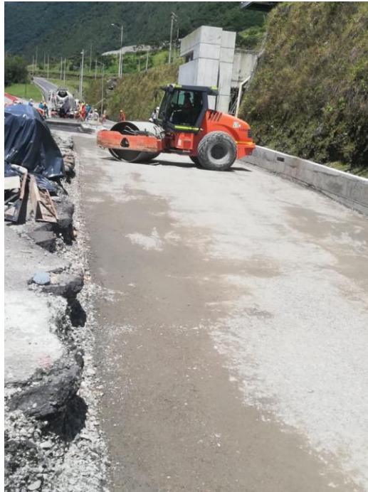
Ilustración 5. Compactación de la Base.
