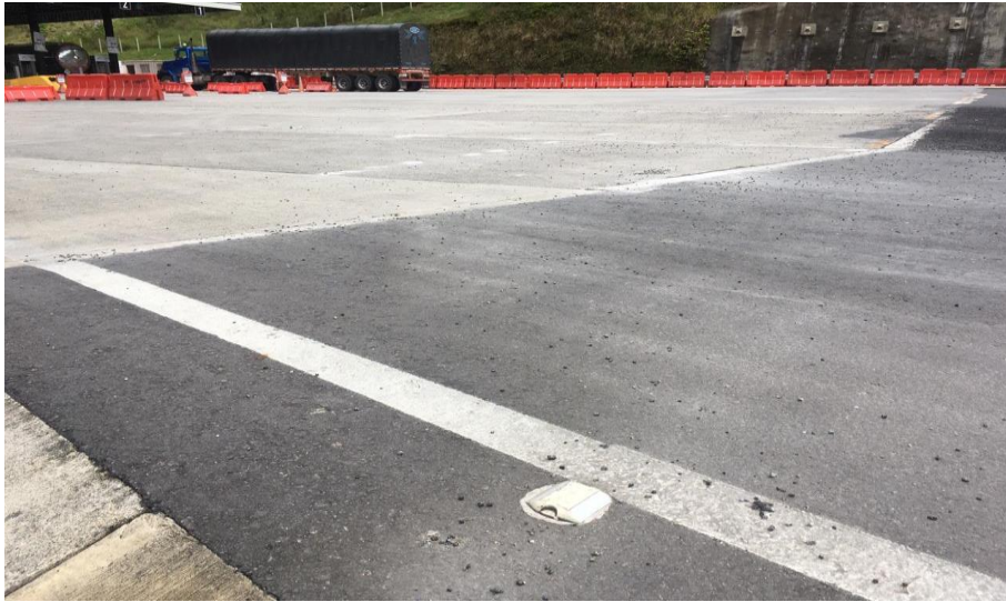
Ilustración 19. Unión MR con vía en asfalto
