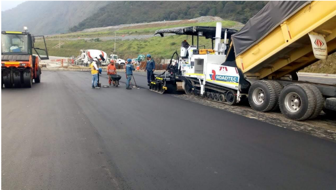
Ilustración 13. Instalación de carpeta asfáltica
