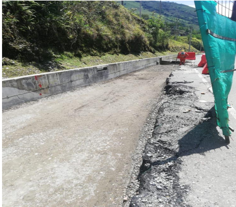
Ilustración 11. Conformación de base granular
