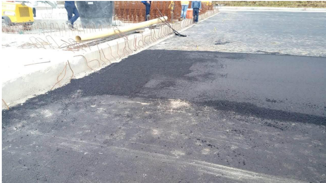
Ilustración 12. Imprimación con lechada asfáltica y primera capa de asfalto
