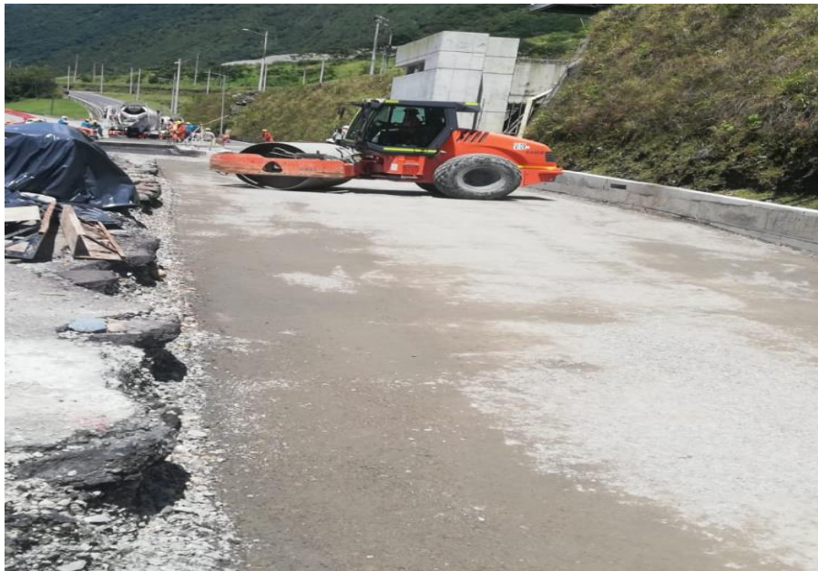
Ilustración 10. Vibro compactación de la base para imprimación
