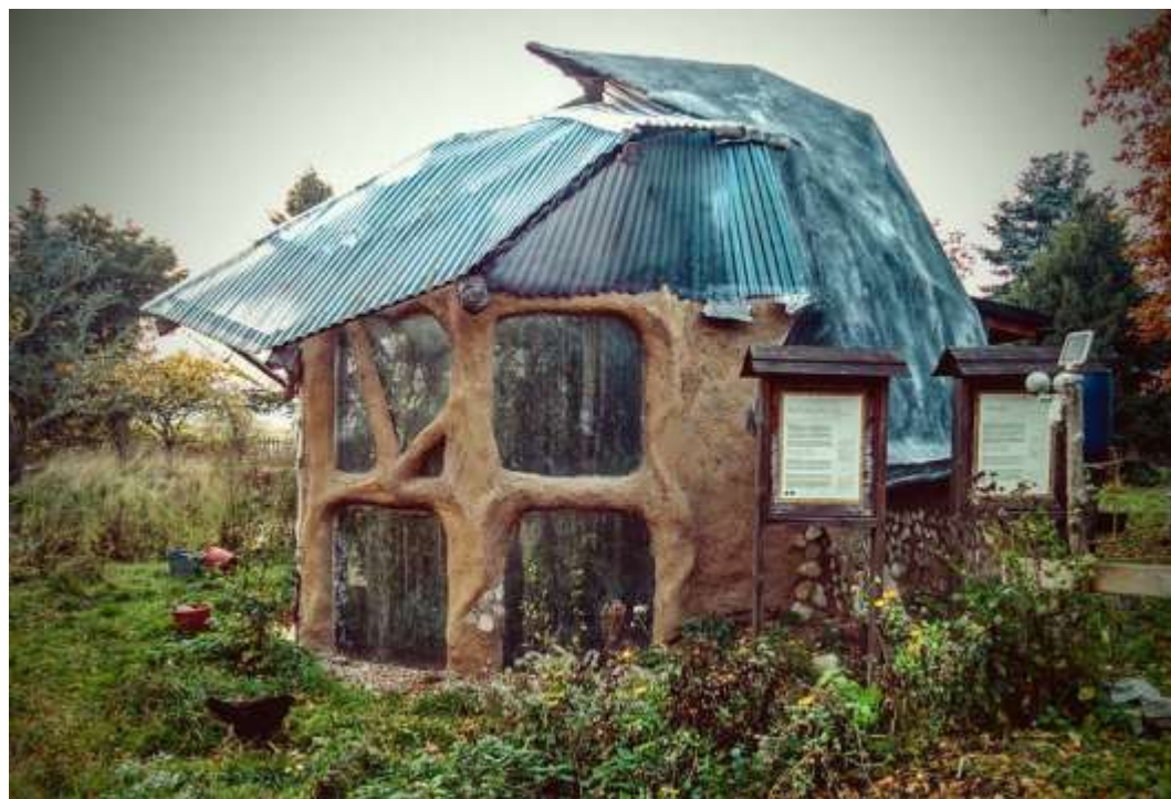
FIGURA 12. CASA DE DUCHAS EN SUDERBYN PERMACULTURE ECOVILLAGE. TOMADA DE
