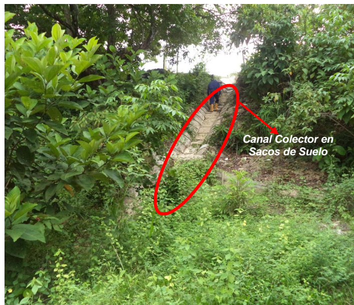
Figura 27. Muestra de un canal colector en sacos de suelo cemento que ya se encuentra revegetalizado.
