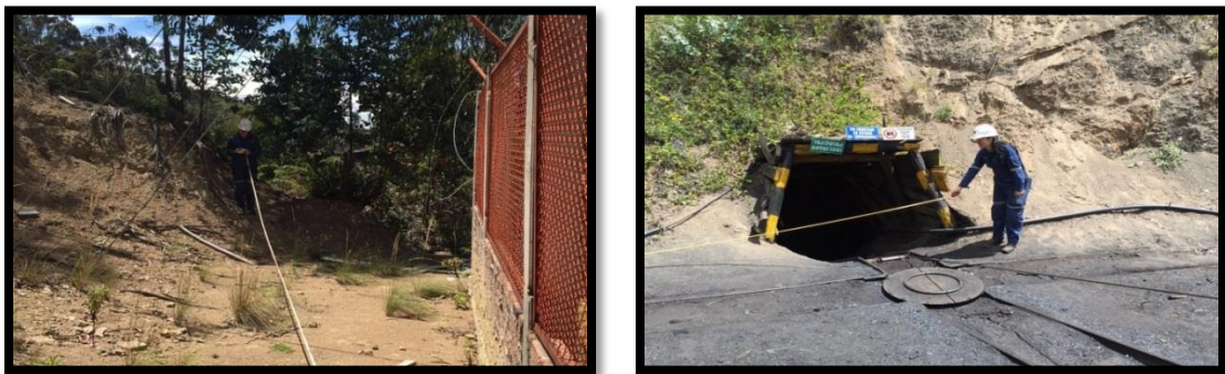
Figura 37. Medición en subestación y adyacente a la mina. Fuente: La Autora, 2016.
