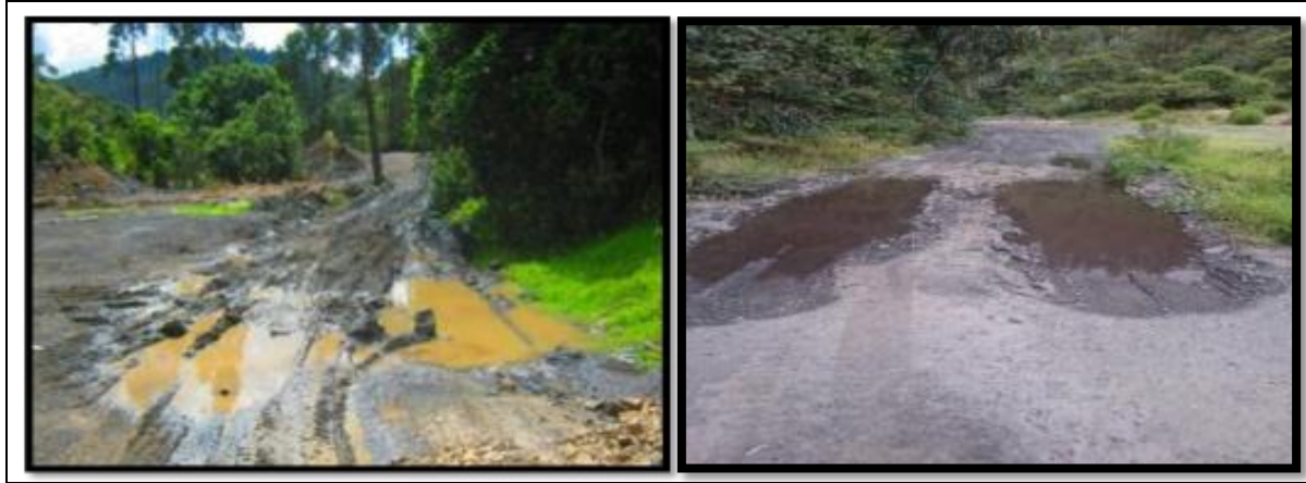
Figura 10. Inadecuado manejo de aguas lluvias en patios de acopio. Fuente: La Autora, 2016
