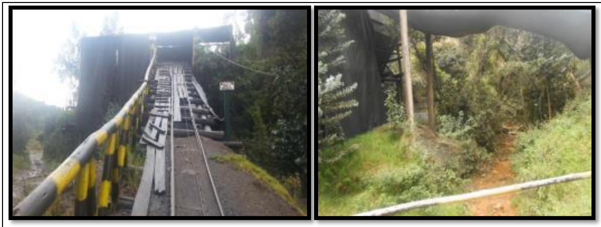
Figura 15. Tolva ubicada sobre la quebrada Agua Blanca. Fuente: La Autora, 2016
