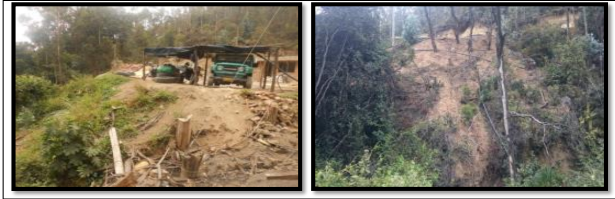
Figura 16. Afectación morfológica cerca a la Quebrada Agua Blanca. Fuente: La Autora, 2016.
