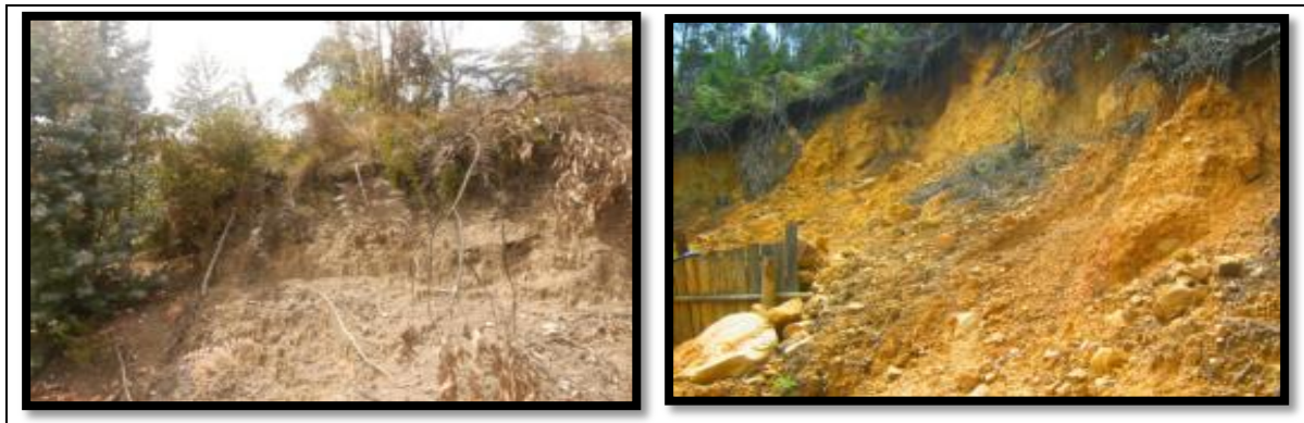
Figura 18. Deslizamiento en las vías de ingreso. Fuente: La Autora, 2016
