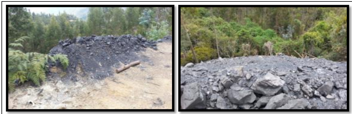
Figura 21. Disposición inadecuada de material estéril. Fuente: La Autora, 2016
